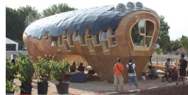
Fassadenintegrierte Fotovoltaikanlagen beim Solar Decathlon 2010
