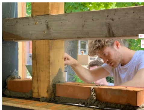
Praxislabor Bauphysik: Herstellen von Ziegelwänden und hygro-thermische Messungen an einer innengedämmten Fassade durch Studierende
