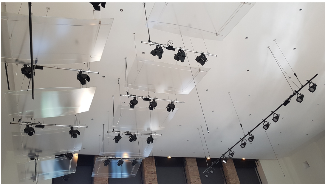
Nach der Sanierung: Äußerlich fast unverändert, jedoch mit energiesparender LED- Technologie
